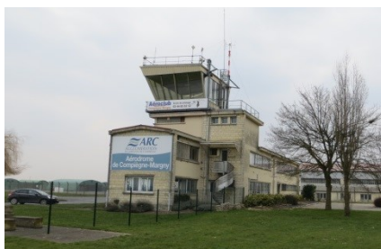
Façade Nord-Est - AVANT TRAVAUX
