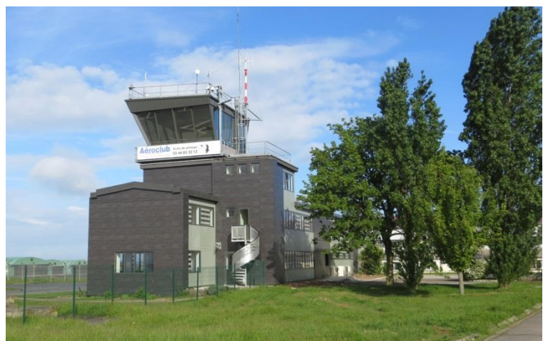
Façade Nord-Est - APRES TRAVAUX
